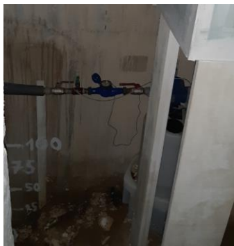
Photo 3 : Compteur d'eau dans le vide sanitaire du Bâtiment RIMBAUD
