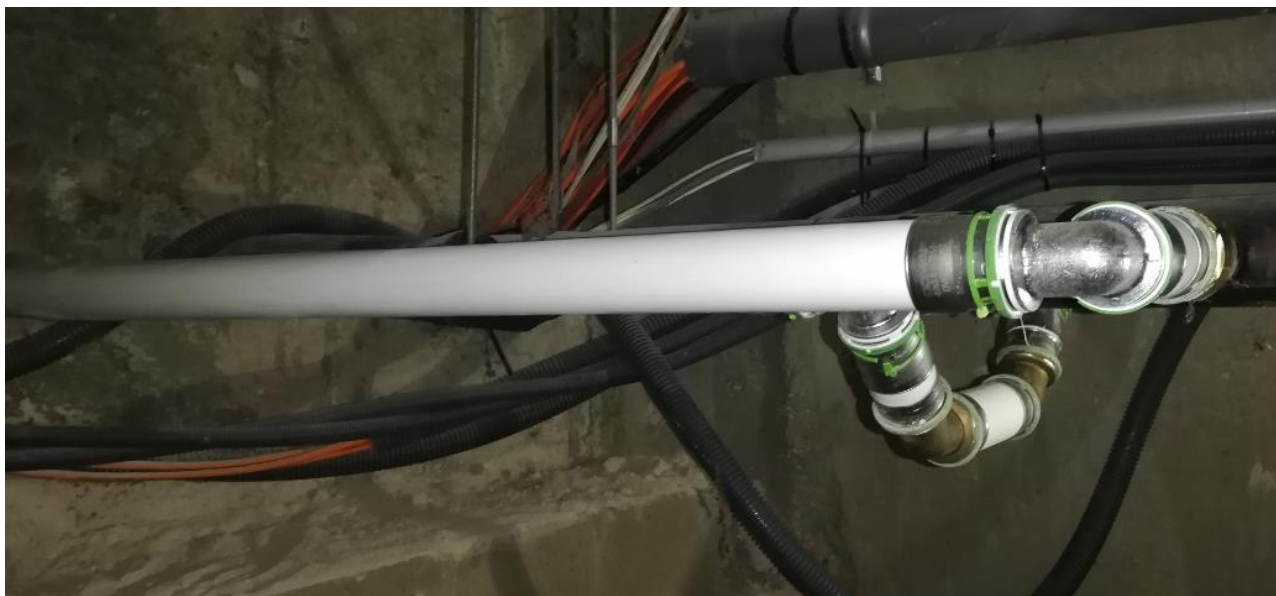
Photo 8 : Réseau nouvellement changé non-isolé en vide sanitaire sous le bâtiment RIMBAUD
