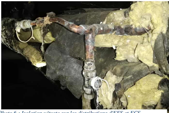
Photo 6 : Isolation vétuste sur les distributions d'EFS et ECS
