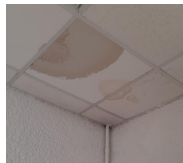
Photo 1 : Traces d'humidités au RDC bâtiment VERLAINE
