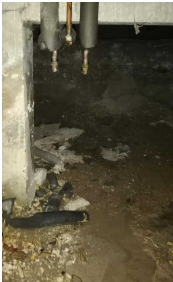
Photo 10 : Fuite sur le retour ECS dans le vide sanitaire sous le bâtiment Verlaine
