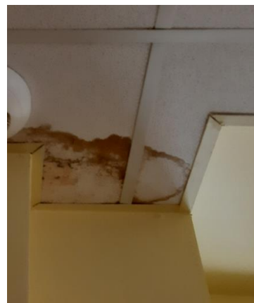
Photo 5 : Traces d'humidités au RDC Bâtiment DUMOTTIEZ
